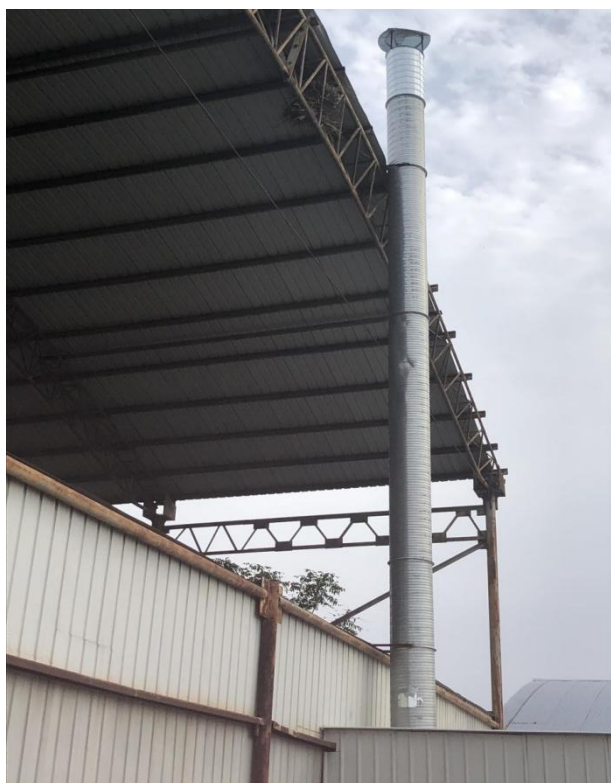
图 4-3 喷漆废气排放排气筒
