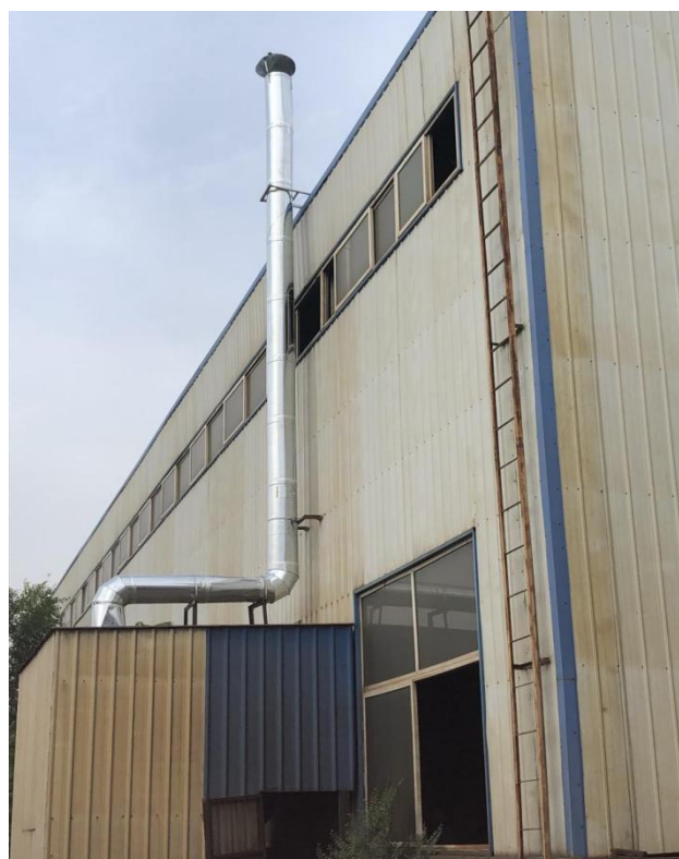
图 4-6 抛丸机排放排气筒
