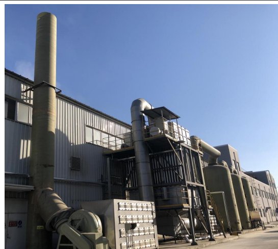
图 3-3 成品车间环保设施+15.1m 高排气筒
