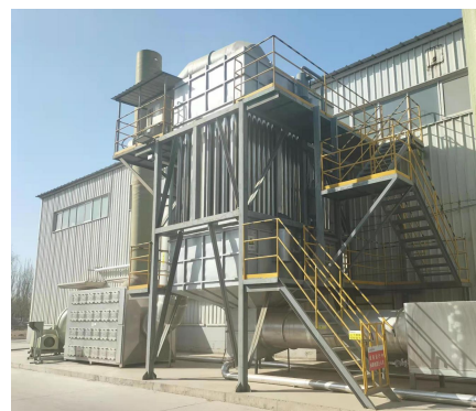
图 3-5 成品车间高能电子裂解装置
