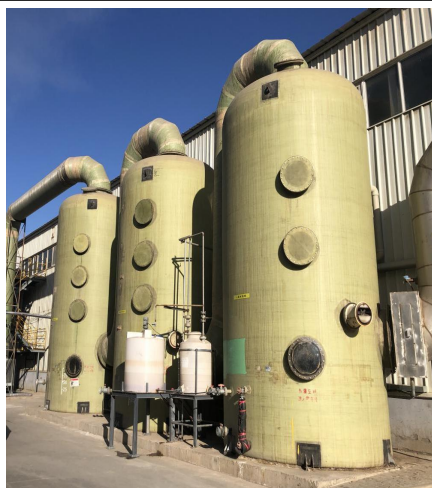
图 3-3 成品车间环保设施+15.1m 高排气筒
