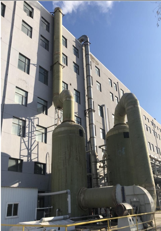
图 3-1 发酵车间环保设施+26.1m 高排气筒
