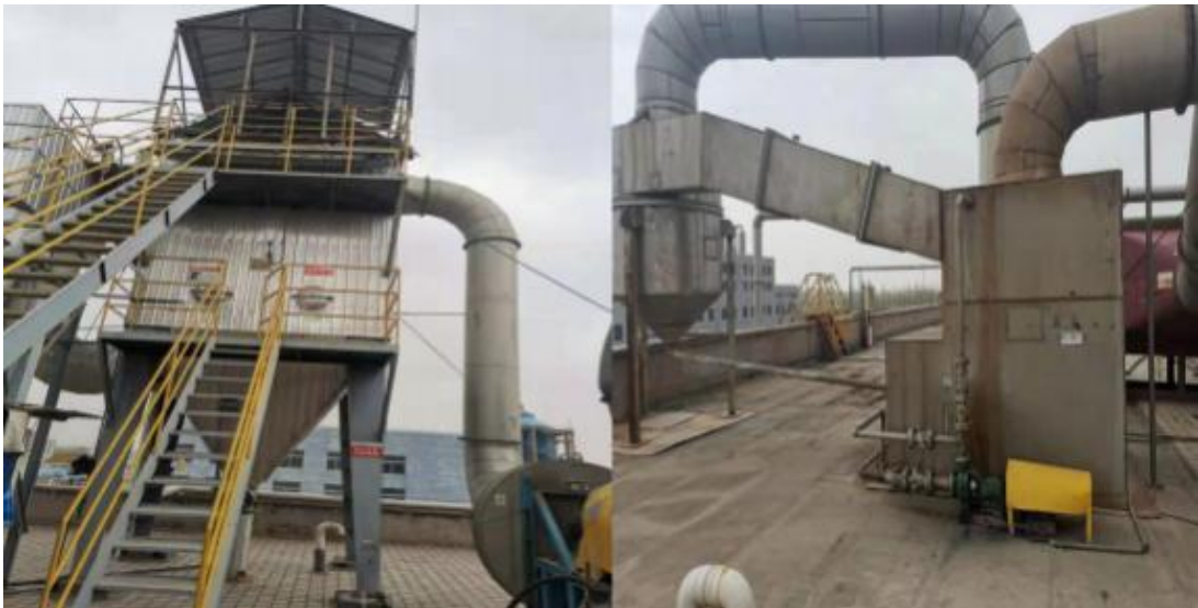
图 3-2 成品车间布袋除尘器+水浴除尘器
