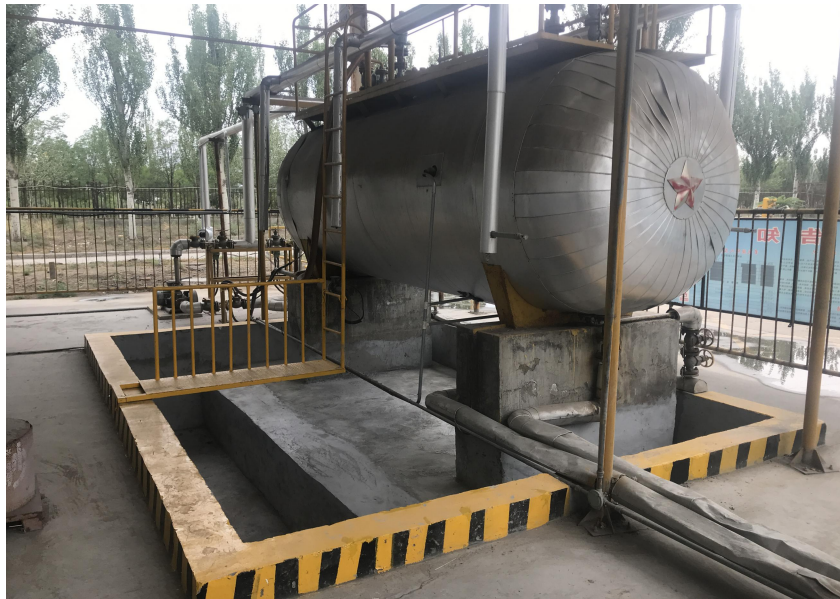
图 5-14 液氮储罐及围堰
