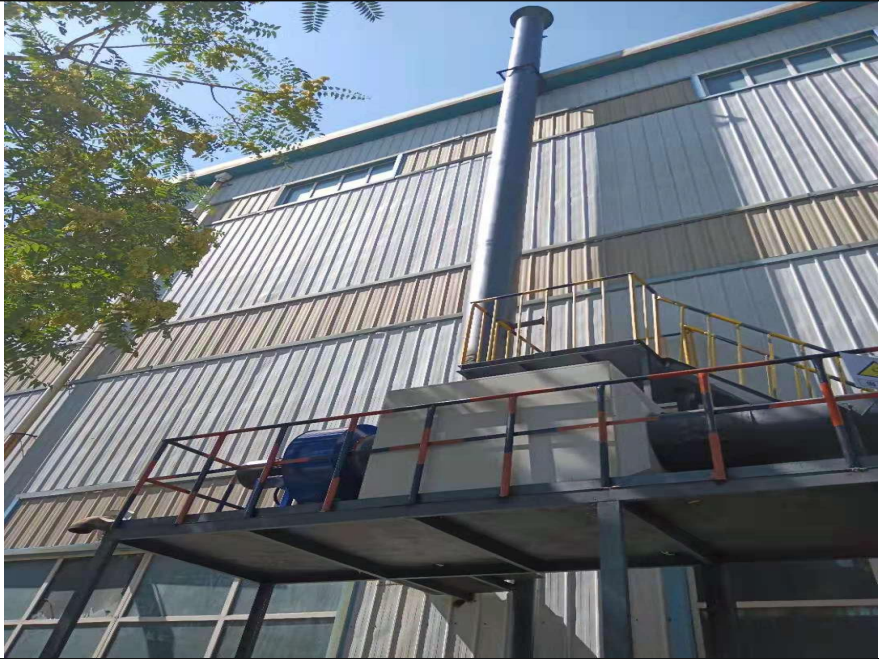
图 5-10 活性炭吸附装置+25m 排气筒
