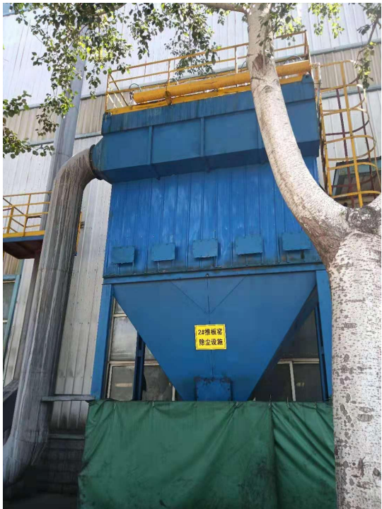
图 5-5 2#推板窑布袋除尘器和排气筒
