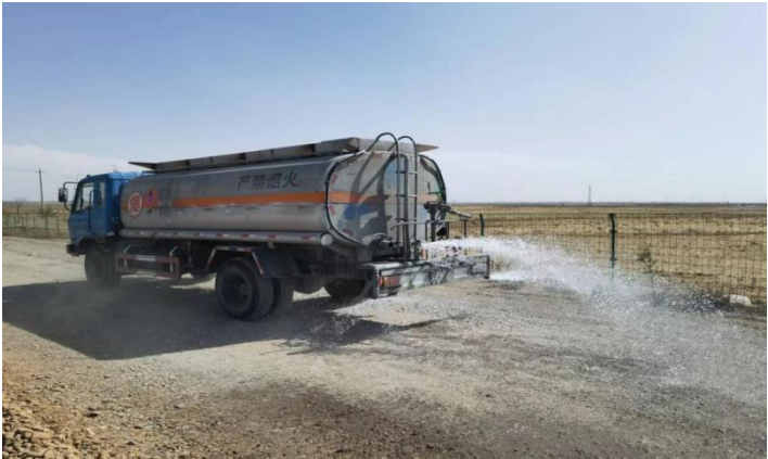
图 4-1 贮存区、运输路面洒水车
