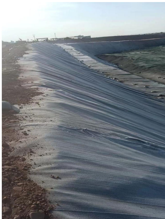
图 3-8 边坡修整及土工膜
