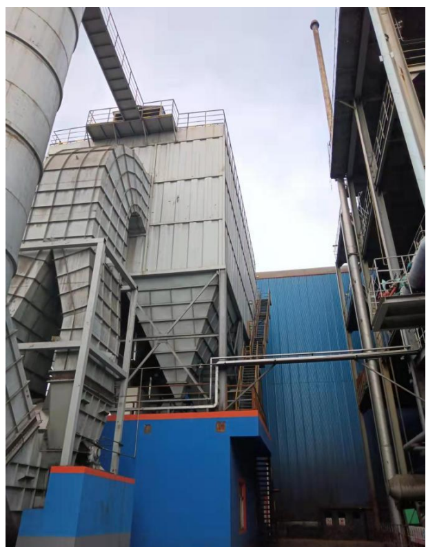
图 5-7 矿热炉布料、出铁口及浇铸废气布袋除尘器
