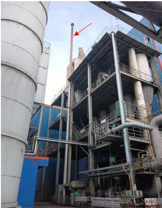
图 5-11 11# 矿热炉 40m 高的事故排放装置 图 5-12 12#矿热炉 40m 高的事故排放装置
