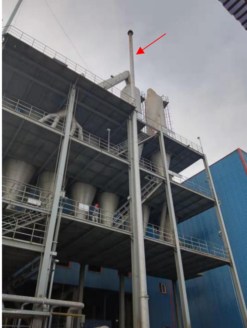
图 5-11 11# 矿热炉 40m 高的事故排放装置 图 5-12 12#矿热炉 40m 高的事故排放装置
