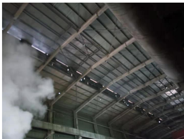
图 5-6 浇铸车间顶吸集气罩
