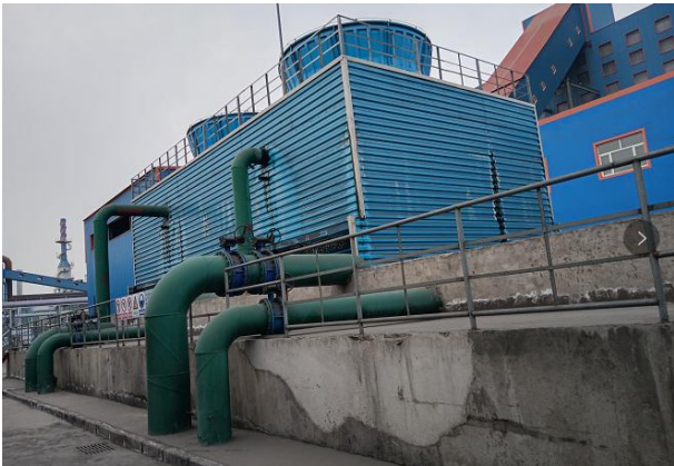
图 5-1 循环冷却水系统
