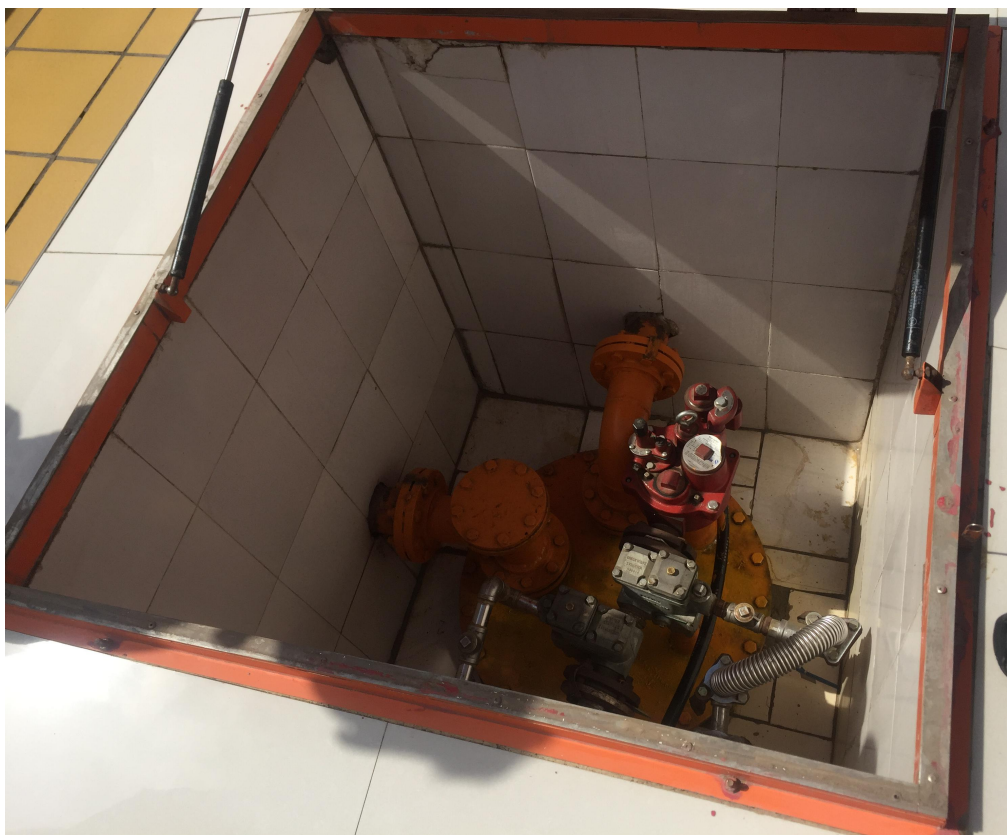
图 3-4 加油站集液罐
