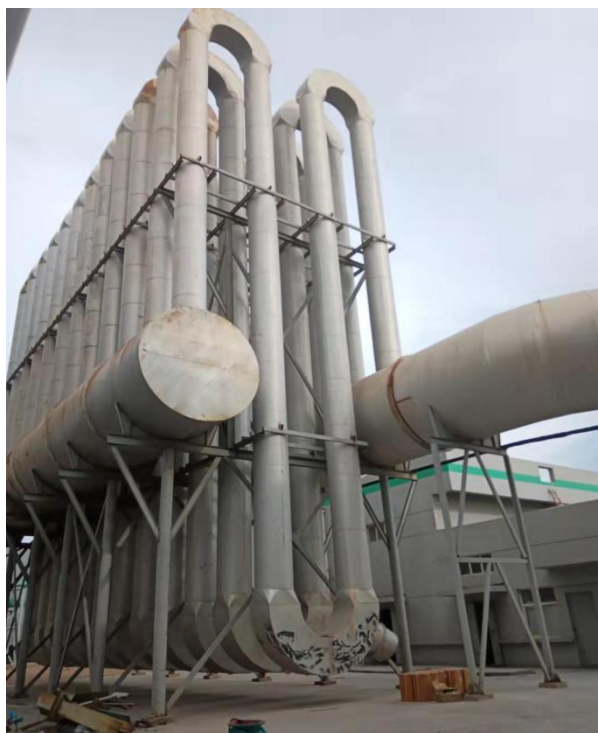
图 4-3 1#矿热炉冷却装置
