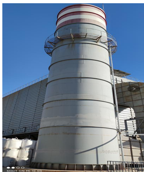
图 4-6 矿热炉 30m 排气筒
