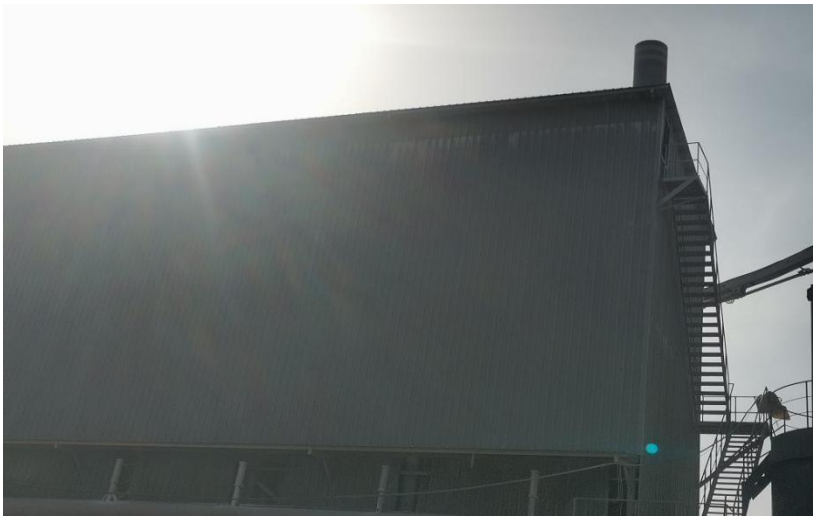
图 4-9 出硅口和浇铸工序布袋除尘器+离地面 23m 高的排气筒
