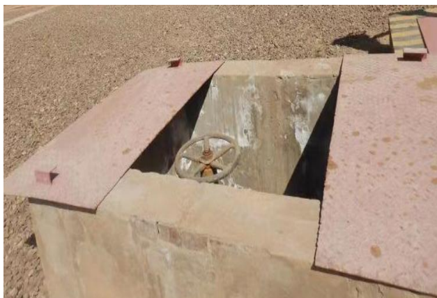
图 5-14 初期雨水池切换阀 5.2.2 地下水污染监控措施
