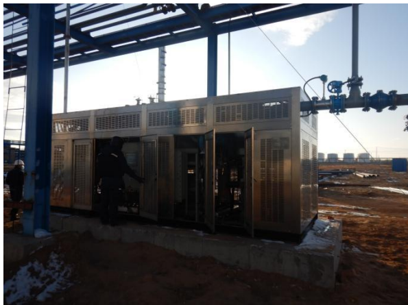
图 5-2 油气回收装置
