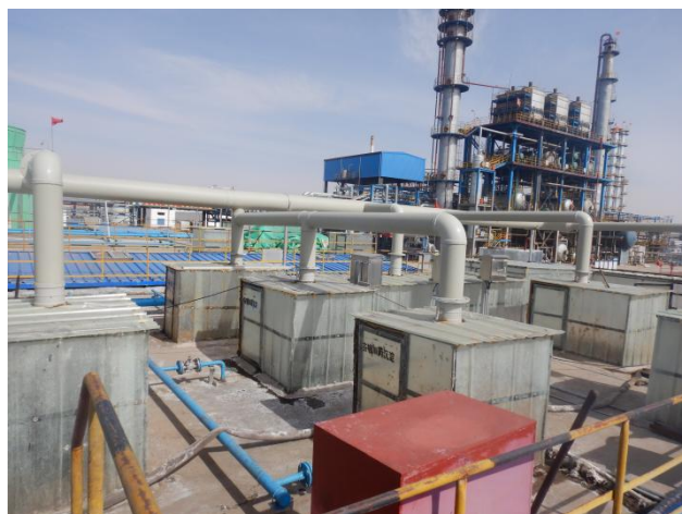
图 5-10 废气收集管线
