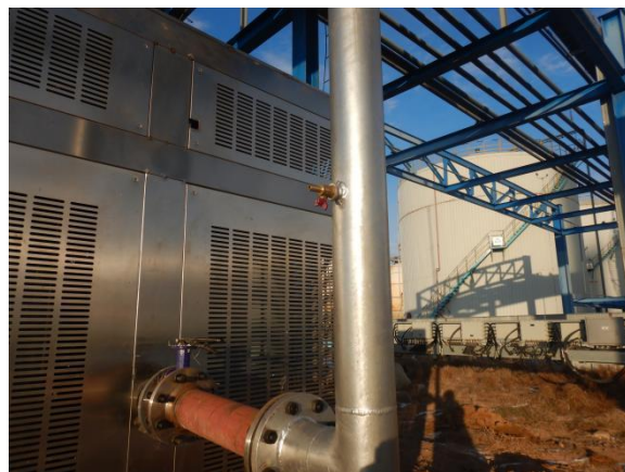
图 5-3 油气回收装置排气筒
