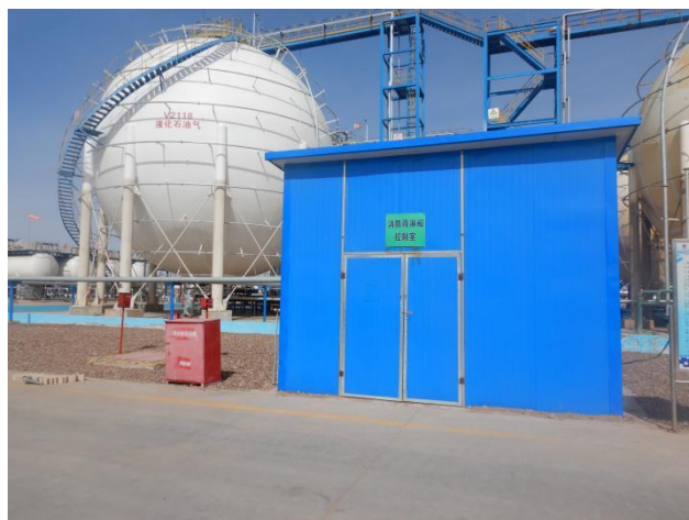
图 5-15 球罐区消防雨淋阀控制室
