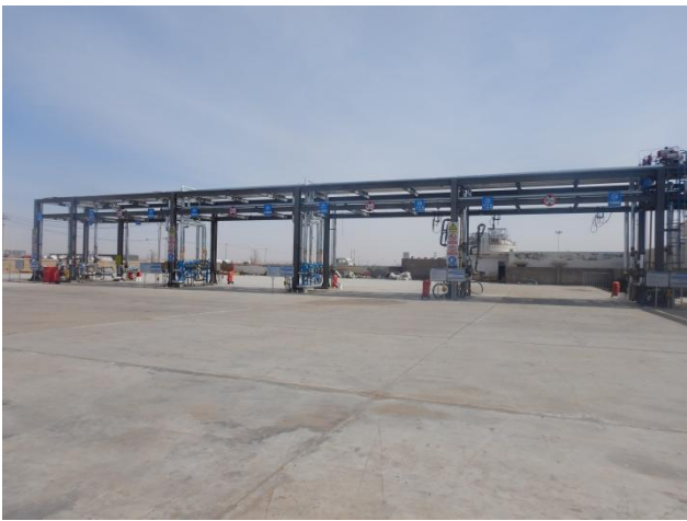
图 4-6 新增 5 个装卸车栈台
