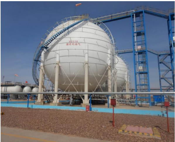
图 4-5 新建 2 座 3000m³ 球罐
