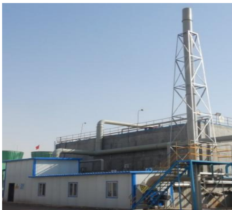
图 5-6 污水处理站废气收集装置及排气筒
